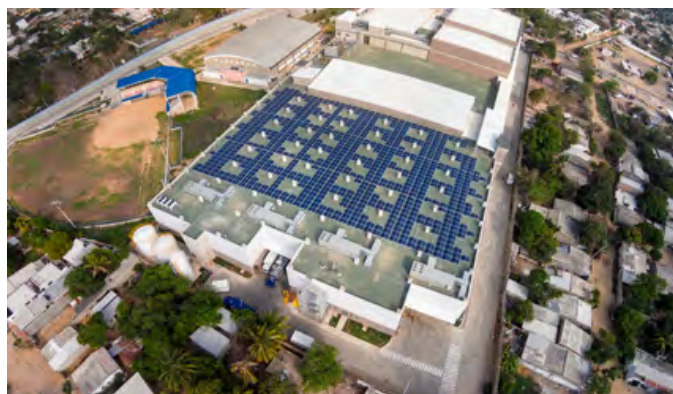
Contamos com mais de 16.520 painéis solares em nossos centros comerciais e armazéns; 5% a mais do que em 2023 graças à inauguração da planta fotovoltaica em VIVA Wajira, Riohacha, Guajira.
